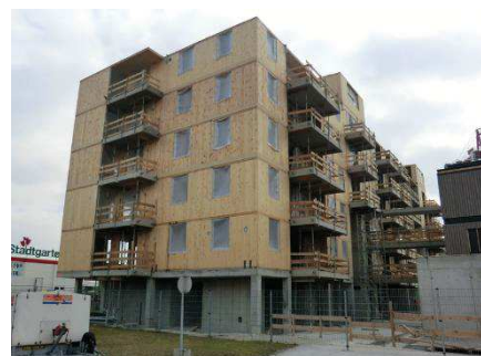
図3 7階建ての木造建築物の建設現場 (オーストリア・ウィーン市内)
