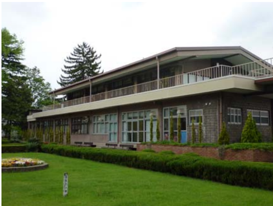
UUプラザ (スチールサッシが残る)
