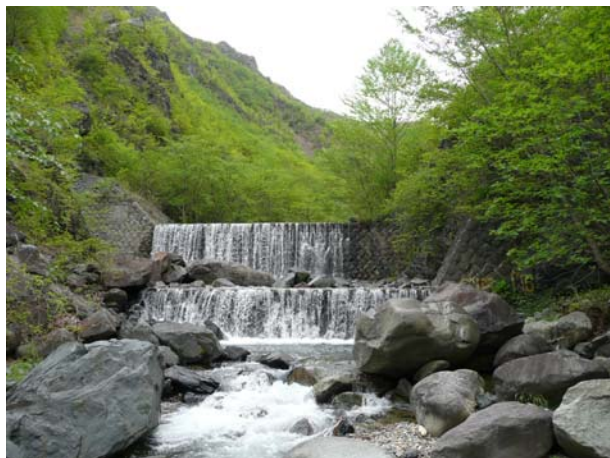
井戸沢口砂防堰堤
