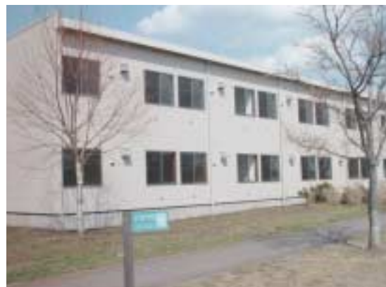
2005年3月下旬に完成した新サークル棟(第I期分)
