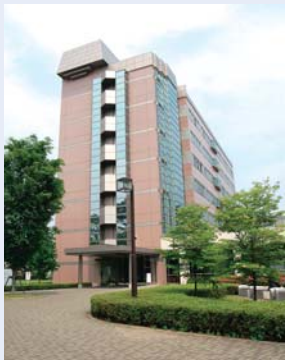
センターが開設された隔東キャンパスのエネルギー環境棟
