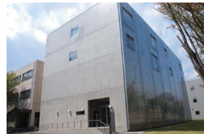
建物の東側の壁がオプティカルウォール（ステンレス製の板）で覆われており風によりキラキラ光ります。
