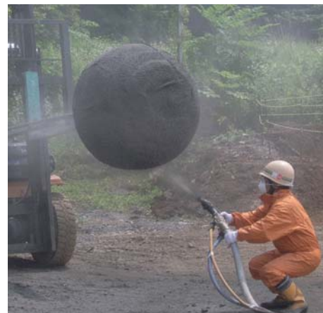
1km圧送の後に、球体に吹き付けるキロフケール
