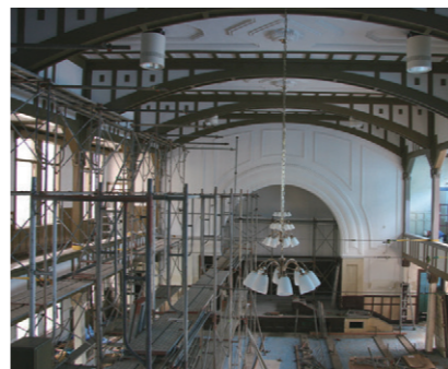
改修工事の様子
