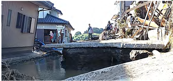
平成27年関東・東北豪雨での鬼怒川決壊口付近の被災状況
