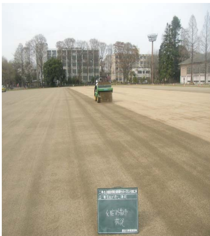
グラウンド改修工事
